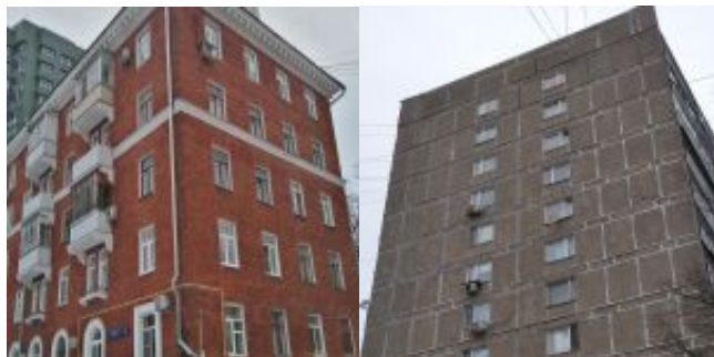
Рис. 1. Изображения фасадов здания из набора данных
