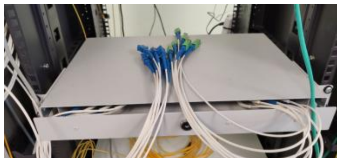
Рис. 3. Научно-исследовательский стенд с многосердцевинным волокном
